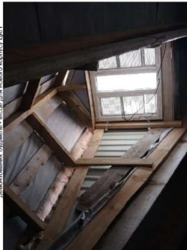
Слухове вікно на горіщі слухові вікна та інші світлопрорізи конструкції і проходів інженерних мереж мають не естетичні примикання, що погіршує енергозбереження будівлі зсирому
