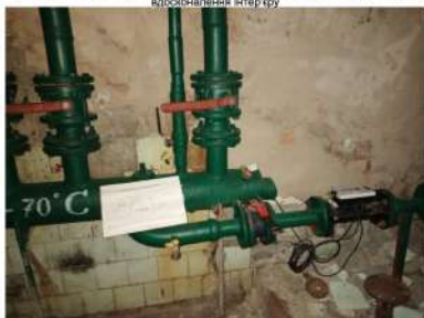
тепловий пункт система підключення тепломережі може бути вдосконалена для збільшення енергоефективності будівлі
