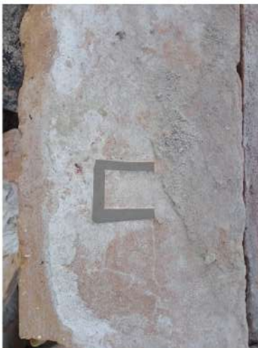
Цегла заводу Попова цегляні фасади старого міста, в тому числі Будівлю ЦКП, мають історичну цінність та мають бути збережені, цегла з літерою "П" - маркери туристичних місць
