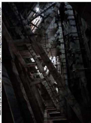
Конструкції горіща Дерев'яні конструкції горіща не мають біо-та асептичності, усталіліні горіща не відповідає нормам ДЕН
