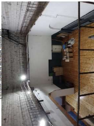
Конструкції горіща Дерев'яні конструкції горіща не мають біо-та асептичності, усталіліні горіща не відповідає нормам ДЕН
